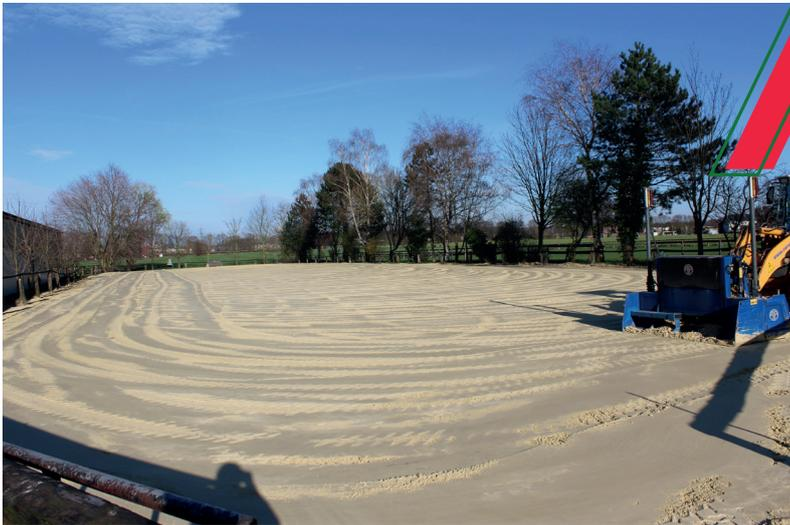
Im Anschluss kommt auch hier wieder der Grader des Reitplatzbauers zum Einsatz. Die neue Tretschicht wird gleichmäßig, ca. 12 cm stark, auf dem Reitplatz verteilt. Zu beachten ist hier, dass auch in der Tretschicht das benötigte Gefälle beibehalten wird.
